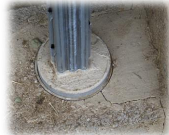
Le manchon est installé dans une base en béton
